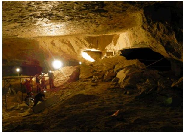
Il costante monitoraggio della cavità ha mostrato una sostanziale stabilità nel tempo delle fessurazioni" e l'influenza del traffico di superficie sulla deformabilità della volta della cavità. Dunque il **10 luglio 2012** sono state revocate in parte delle limitazioni al transito dei mezzi pesanti mentre mezzi di trasporto pubblico e della nettezza urbana potranno transitare senza limitazioni di carico.
